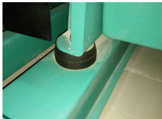
图 6.2-8 备用发电机减震基座
